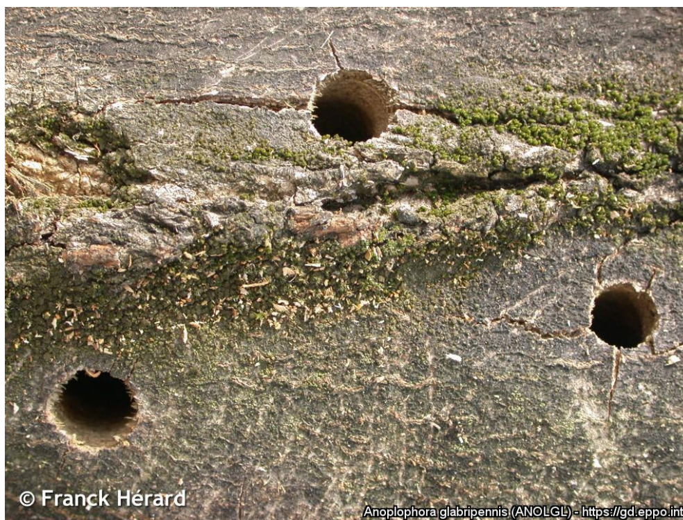
Výstupové otvory (Zdroj - https://gd.eppo.int/taxon/ANOLGL/photos )
